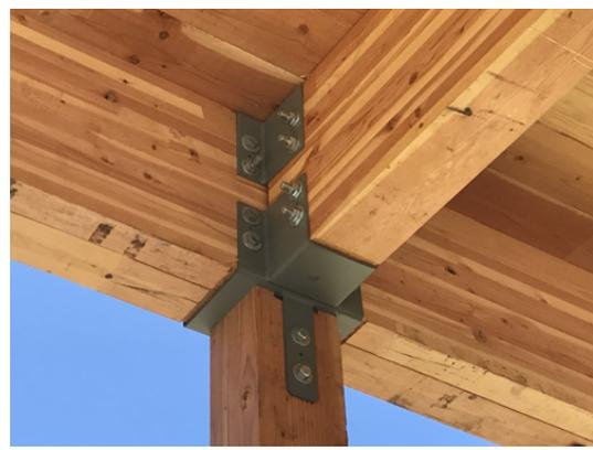
(d) Beam-to-column joint
